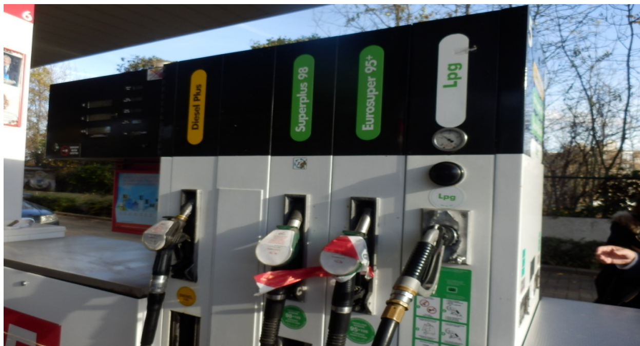
同一アイランド内に設置されたマルチディスペンサー
