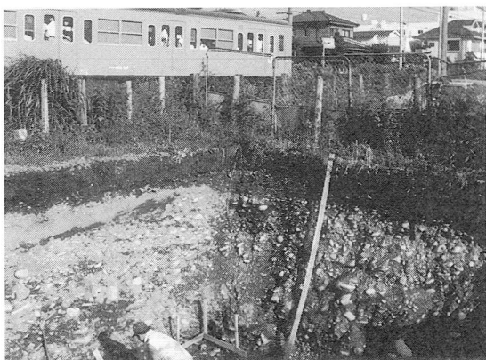
図 VIII-10 拝島段丘を構成する拝島レキ層 (福生駅北 西方の防火用水槽建設時に露出)
