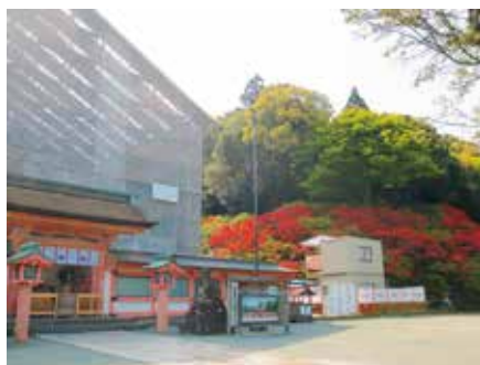
社殿覆い屋・久留米つつじ原木群をのぞむ
