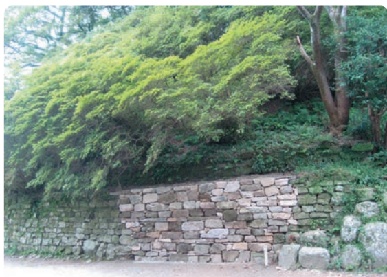
久留米つつじ原木群下の石垣の復旧
