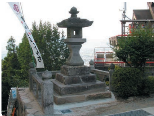
修復後の石灯笼・玉垣・石垣
