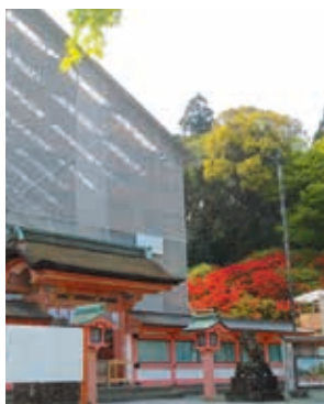
工事中の社殿・久留米つつじ原木軒
