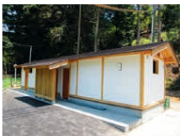
高良会館一階前トイレ工事
