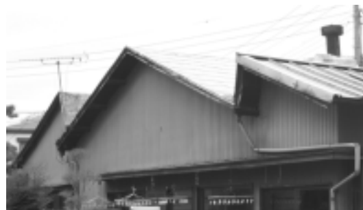
(写真9) 1連+切妻+1連のノコギリ屋根工場
