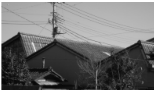
(写真8) 2連+切妻+1連のノコギリ屋根工場
