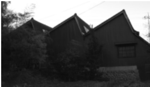
(写真10) 増築部分
