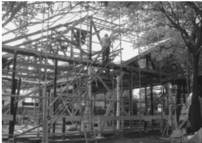
作家集団によって再生工事中の森芳工場。壁も天井もいねいに手作業で解体され、骨組みだけになったところ。ブーリーは象徴として残された
