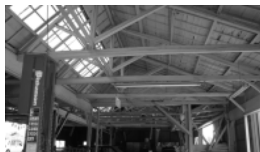
(写真 15) 繊維業以外の用途のノコギリ屋根工場(内観)
