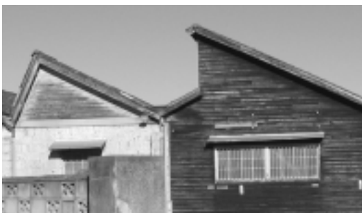
(写真1)異なる傾斜の採光面が混在する事例
