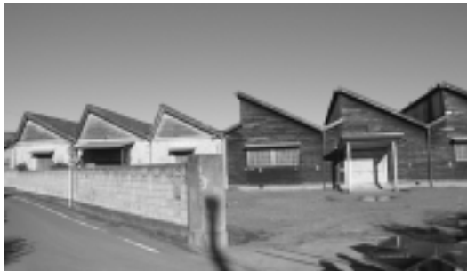
(写真6) 混構造の事例1
