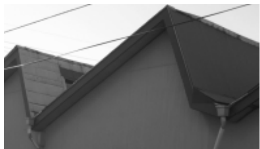
(写真4)連によって採光面の開閉状態が異なる事例
