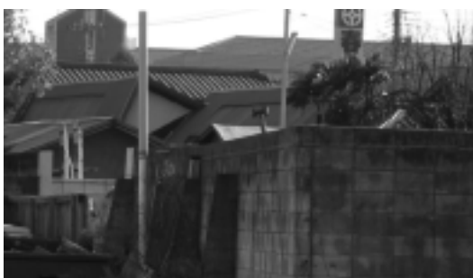
(写真 14) 繊維業以外の用途のノコギリ屋根工場(外観)
