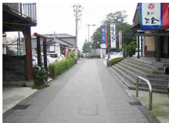
石畳で整備された寺町の道路
