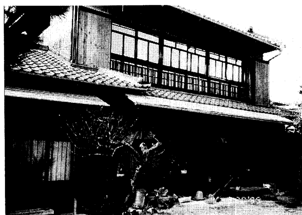
写真 追14 No.15 I邸 (芦屋市船戸町) 大正末期の和風住宅、 左側にステンドグラスの欄間のある応接間が付く。 この住宅は倒壊を免れた。
