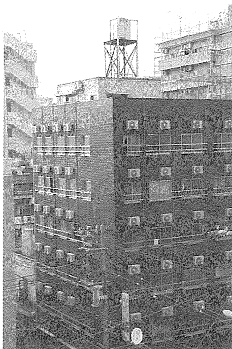
写真⑤小さな窓に張り付いたクーラーの室外機
