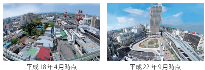
写真－3 武蔵小金井駅南口の状況
