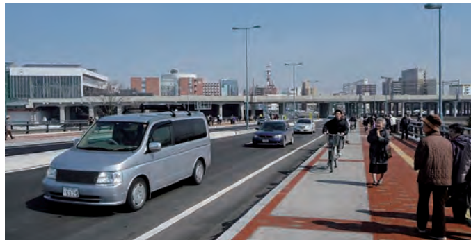
写真-5 鉄道高架と氷点橋の供用による市民の往来
