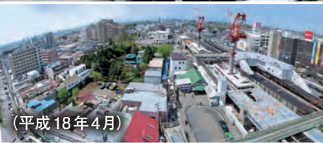
外壁を工事中のJR旭川駅
