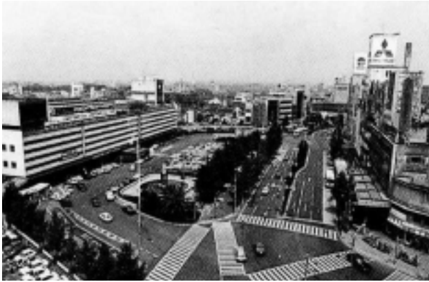
図-3(1) 駅前広場整備事例(愛知県豊橋駅、整備前)
