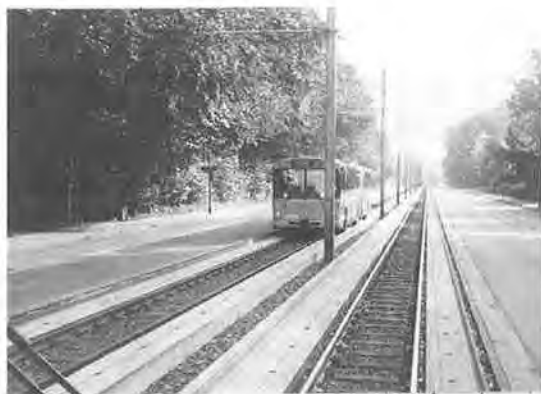
写真-2. エッセン市内を走るOバーン(路面電車レールと軌道バスL型コンクリート版の併用軌道敷)
