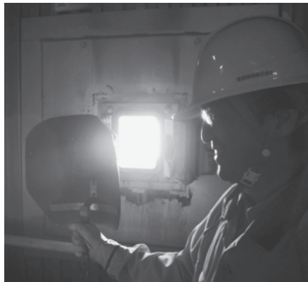
図7 ボイラ内部を防熱面越しに観察
