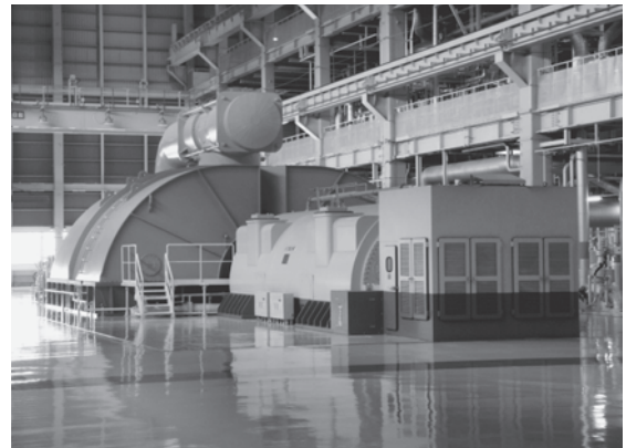
図8 新2号機のタービン発電機
