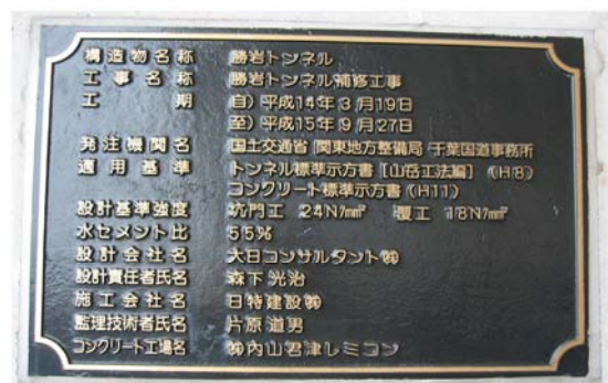
写真3-5 勝岩トンネル補修工事のトンネル銘板
