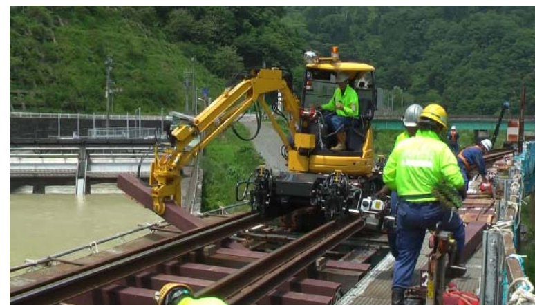
橋マクラギ交換機 (株式会社ケー・エス・ピー提供)
