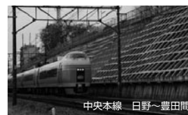
中央本線 日野~豊田間 切取りの面工(吹付枠工)
