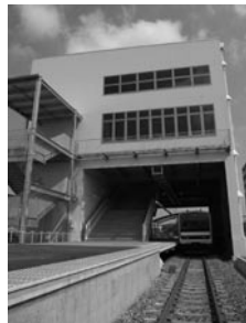
Smart Station 実験棟
