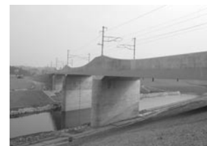
東北線平泉～前沢間衣川橋りょう
