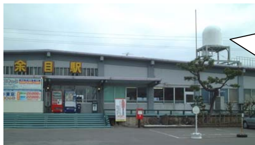
羽越本線余目駅に設置されたドップラーレーダー
