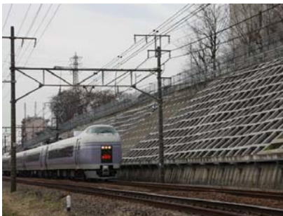
切取のり面工（吹付枠工）
