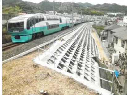
盛土のり面工（吹付枠工）
