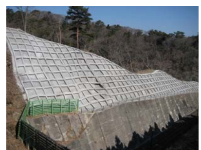
自然斜面防護工（吹付枠工）
