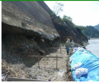
59k910m、60k450m付近 護岸壁洗掘
