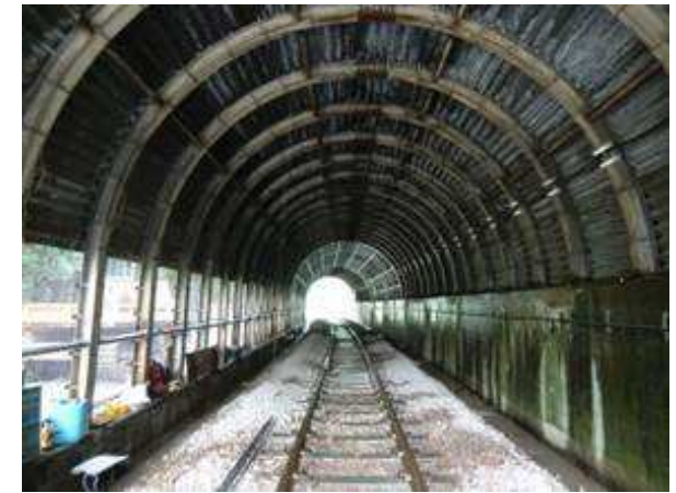
89k820m付近(第1赤沢雪覆い工) (施工後)
