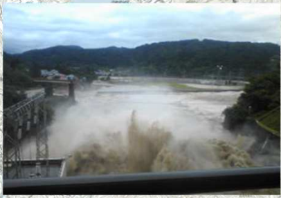
64k090m付近 第6只見川橋りょう桁流失
