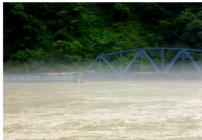
81k420m付近第8只見川橋りょう付近 ・橋桁冠水、流木堆積、橋脚洗掘 ・盛土崩壊、路盤沈下、土留壁変状 ・土砂流入、土砂堆積等
