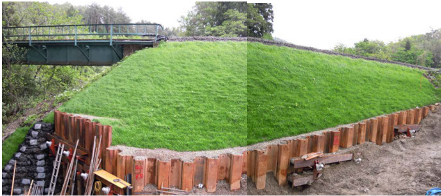
30k700m付近 盛土復旧(施工後)
