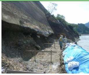
59k910m、60k450m付近 護岸壁洗掘
