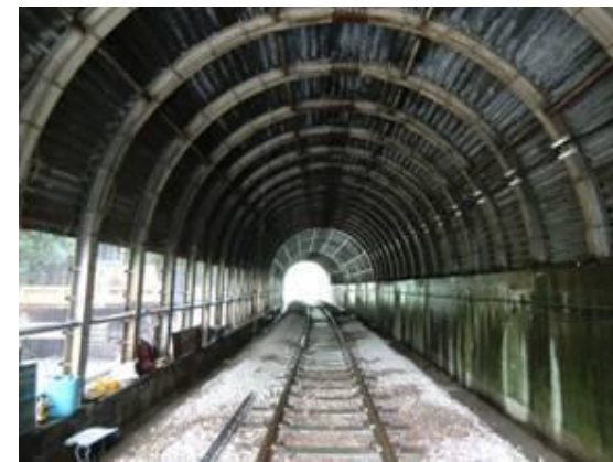
89k820m付近(第1赤沢雪覆い工) (施工後)
