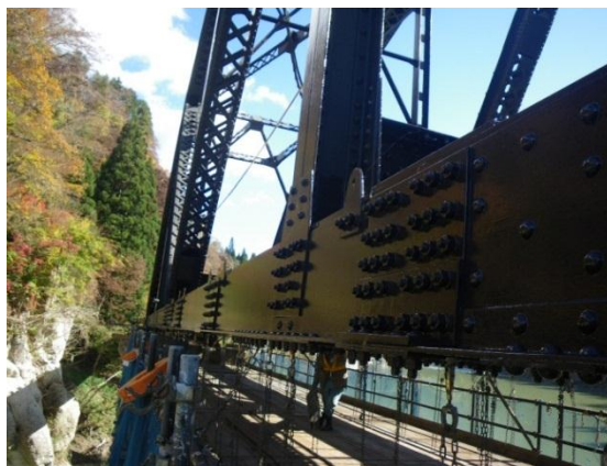
第4只見川橋りょう(施工後)
