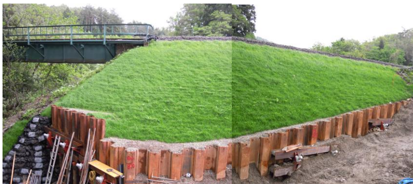
30k700m付近 盛土復旧(施工後)
