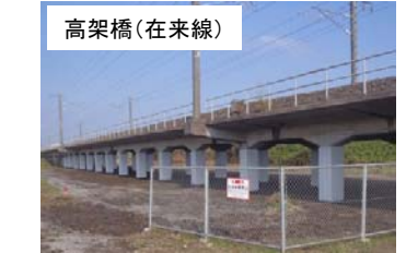
高架橋(在来線) 常磐線 神立・高浜間
