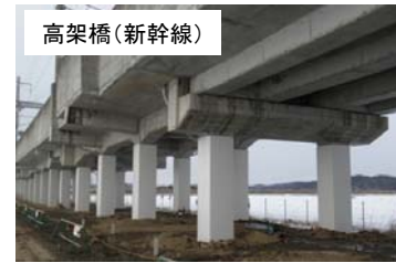
高架橋(新幹線) 東北新幹線 水沢江刺・盛岡間
