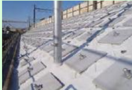
盛土耐震補強
