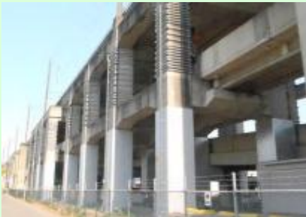
高架橋柱耐震補強
