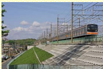
降雨防災対策(のり面補強)
