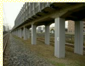
高架橋柱耐震補強
