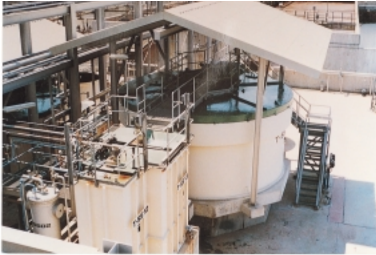
マプタプット工業団地入居工場の悪臭対策がほどこされた施設
