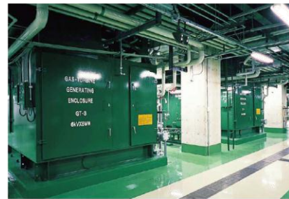
都市ガスによる発電プラント (地下6階)
