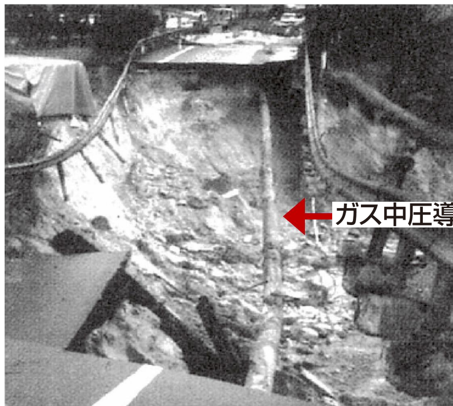
阪神大震災でも被害を受けなかったガス中圧導管
