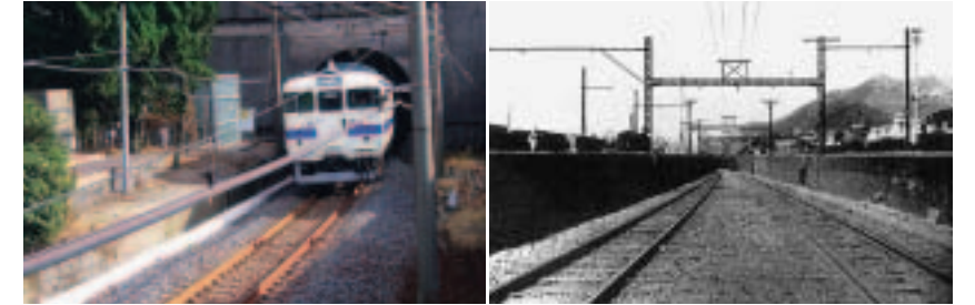
■写真4—一日に約200本の列車が通る(下関側坑口) ■写真5—門司側の坑口
