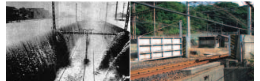
■写真6—昭和28年の大洪水時で浸水する門司側の坑口 ■写真7—下関側の防水扉
