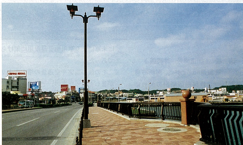
歩道と照明灯
