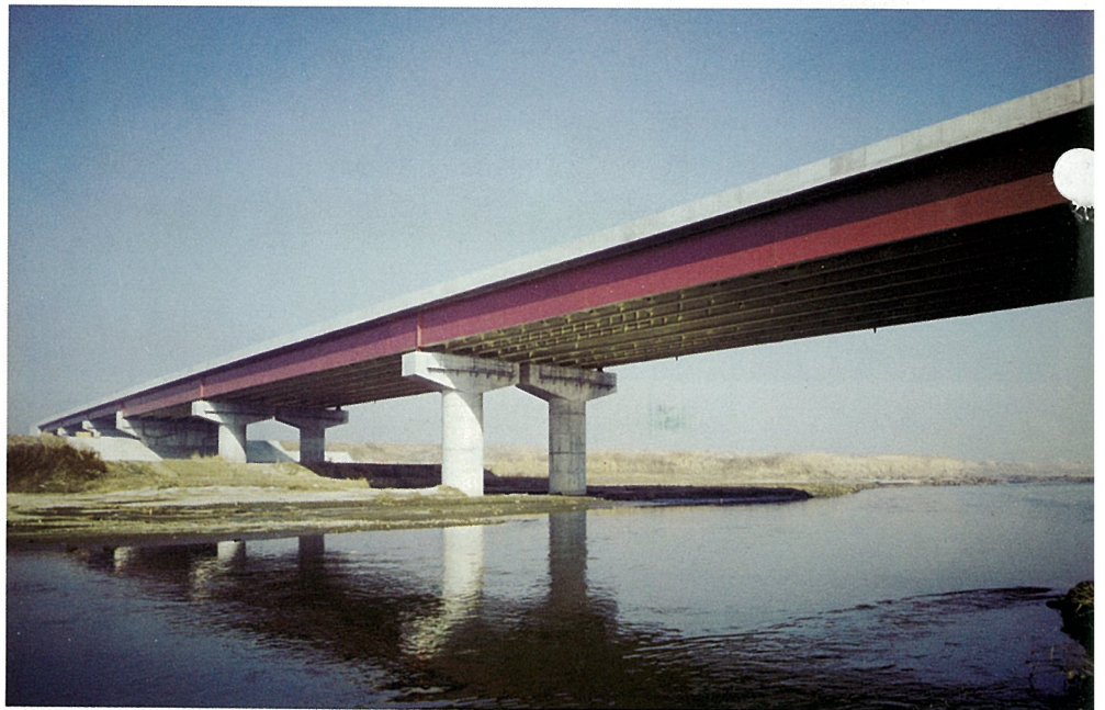
笛吹川橋 発注者 日本道路公団 型式 3径間連続鈹桁 2連 4径間連続鈹桁 2連 橋長 334m 幅員 9m×2 鋼重 1,521t 所在地 山梨県甲府市小曲町字葭原～ 八千代郡中道町大字下曾根
