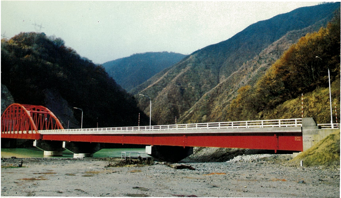
椿原橋 発注者 岐阜県 型式 トラスドランガー＋3径間連続鈹桁 橋長 187m 幅員 8m 鋼重 464t 所在地 岐阜県大野郡白川村内ヶ戸
