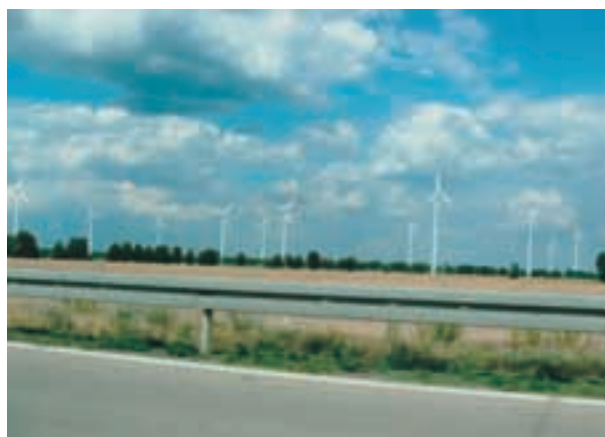
アウトバーンから眺めた風力発電施設
