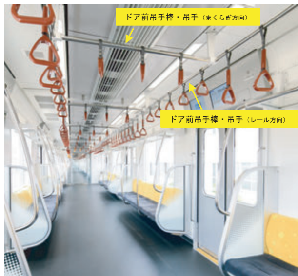
ドア前の吊手棒・吊手の設置 (有楽町線・副都心線17000系)
