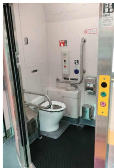
写真-5 普通車トイレ
