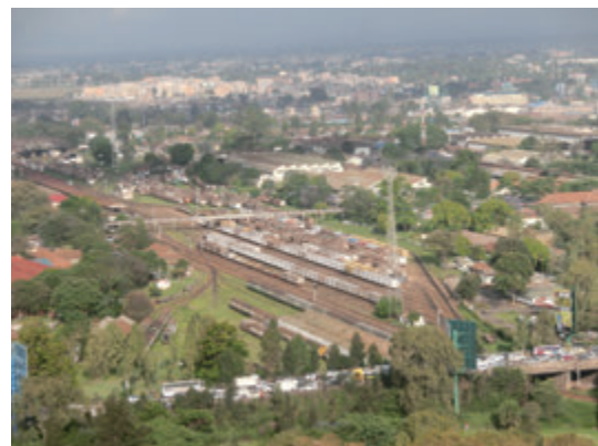
写真-4 ナイロビ駅の構内全体。左側に駅舎、中央部分に貨車の留置線群、その向こうに車両修理工場などが見える。手前のナイロビ～モンバサ道路では、慢性的に渋滞が発生している。(ウエストランド地区の高台にあるビルから東を見る。2014年11月13日)
