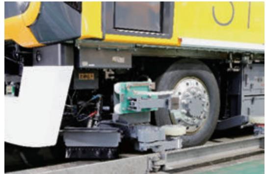
写真11 集電装置（緑部分）
