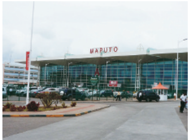
写真-3 中国の資金により建設されたマプト国際空港のターミナル=ビル。(2012年12月6日)
