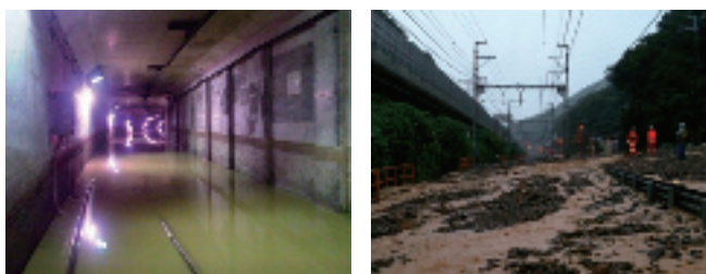
平成25年9月16日 集中豪雨災害状況
