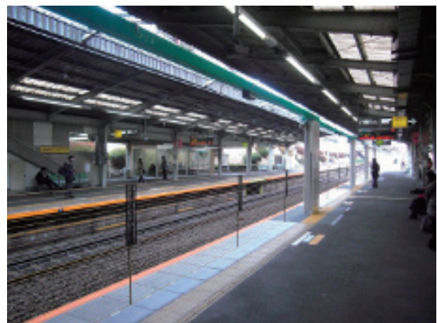
写真1 昇降式ホームドアの外観（東京急行電鉄様 田園都市線つきみ野駅）
