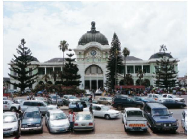
写真-15 白を基調とし一部が薄緑の外観で、中央にドーム状の屋根がある立派なマプト駅。駅舎の2階はCFMの本社になっており、正面中央部にCFMの文字が書かれている。駅前広場に駐車場があるが、列車の乗客用ではない。(西を見る。2012年12月6日)
