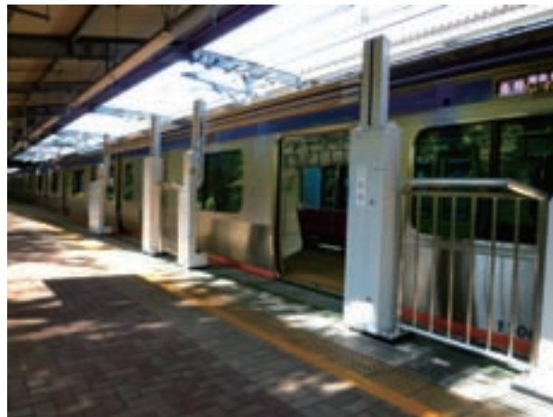
図1 相模鉄道株様弥生台駅に設置した昇降バー式ホーム柵
