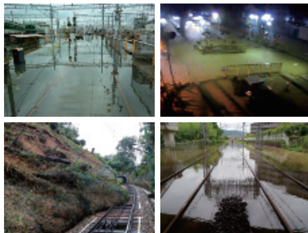
平成24年8月14日 集中豪雨災害状況
