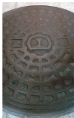
直径92cm、厚さ5cmの鉄製の蓋（地下鉄博物館に展示）
