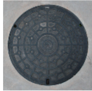
写真4 マンホールの蓋
