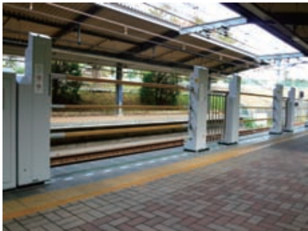
図1 相模鉄道株様弥生台駅に設置した昇降バー式ホーム柵
