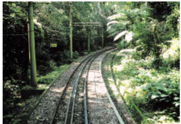
写真-8 コルコバードの丘を上下する登山電車は急勾配なのでリッゲンバッハ式のラックレールを使用している。(麓駅方向を見る。2008年6月29日)
