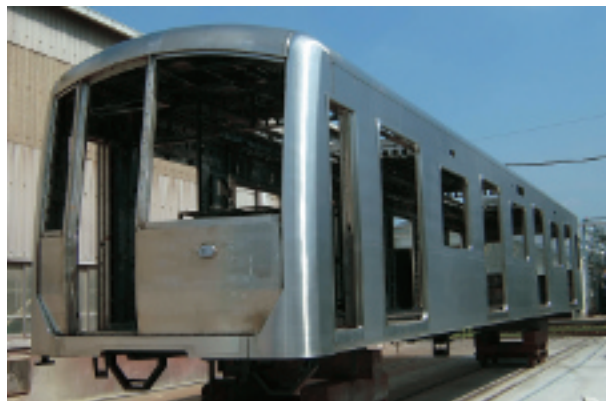
(写真4) 先頭車構体写真
