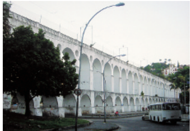
写真-18 1750年に完成したカリオカ水道橋が、向こう側のサンタ=テレザ地区を結んでいて、この上を路面電車が走っている。(南を見る。2008年6月29日)
