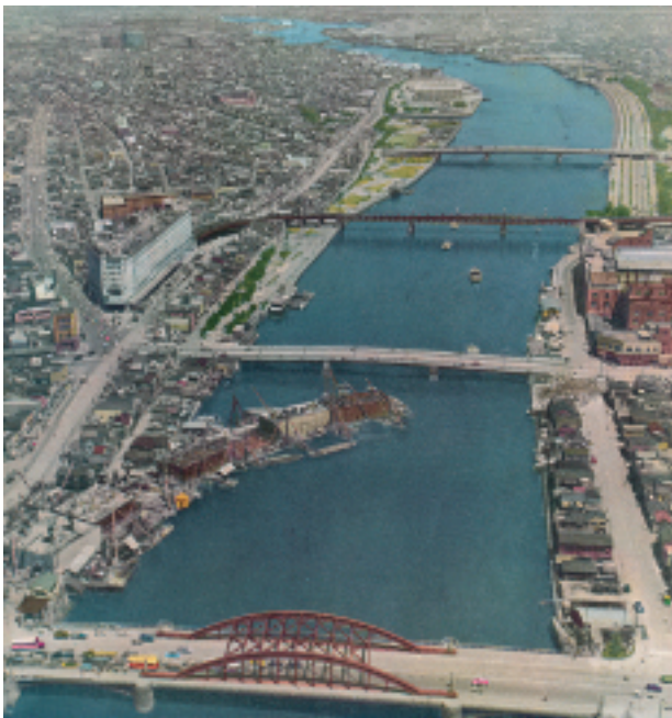
写真-4-3 当時の工事の様子
