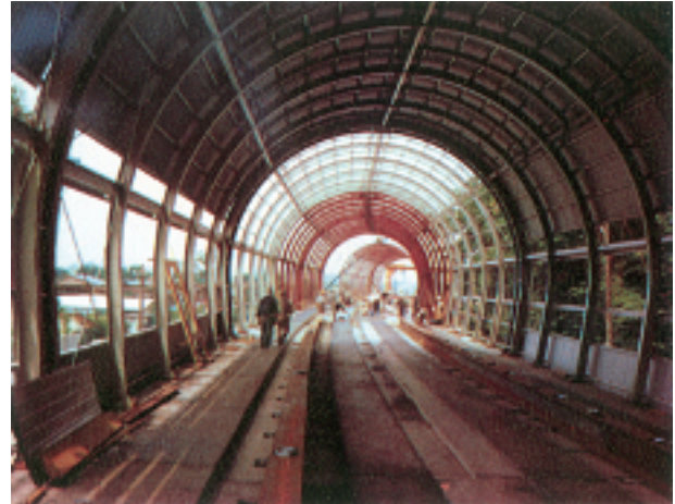
写真-5-7 シェルター
