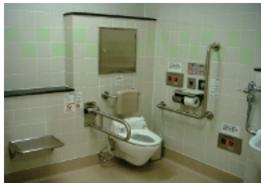
多機能トイレの整備
