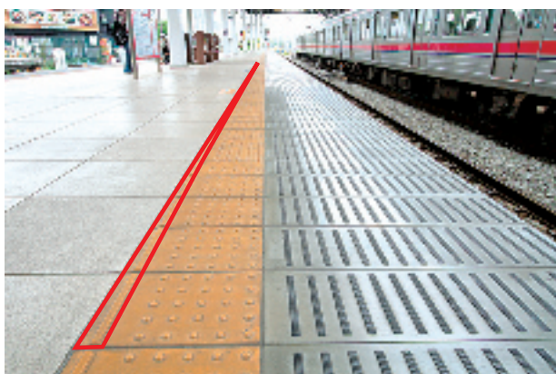
内方線付き点状ブロック
