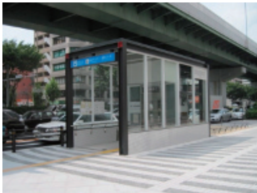
国際センター駅地上行きエレベーター
