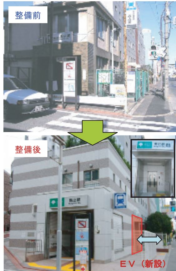
写真1 既存の出入口を改良した例（浅草線馬込駅）
