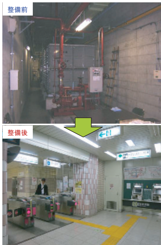
写真5 新たに改札口を設置した例（新宿線瑞江駅）
