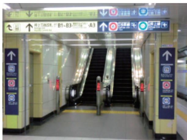
写真3 旅客案内サインシステム
