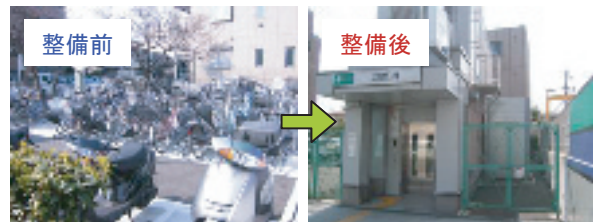
写真2 駐輪場をEV用地として再整備した例（浅草線中延駅）
