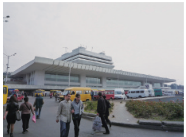
写真-17 グルジア鉄道のトビリシ駅。入口に塀が設置され、全面的な改装工事が行なわれている。(南東を見る。2009年10月18日)
