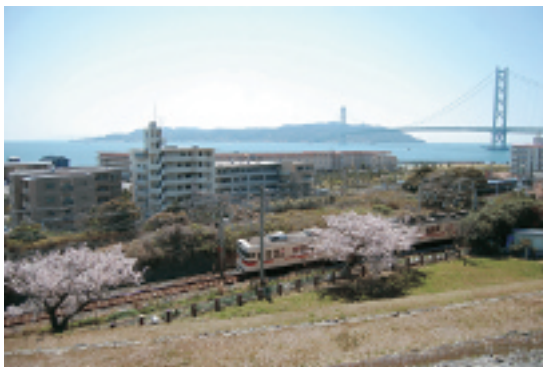
明石海峡大橋
