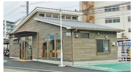
平成27年3月竣工の余戸駅
