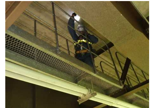
近接目視による点検
