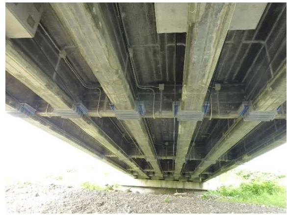
断面修復、電気防食による補修
