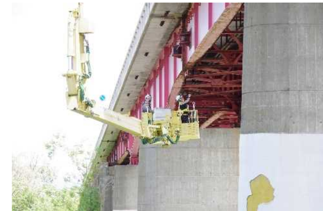
橋梁点検車による点検
