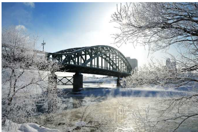
一般国道40号 旭橋（旭川市）
