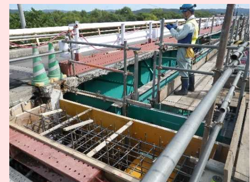
交通規制による「床版取替え」
