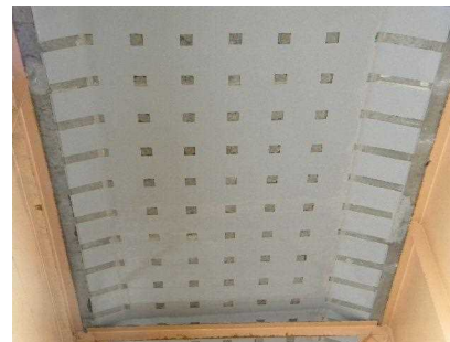
炭素繊維接着補強
