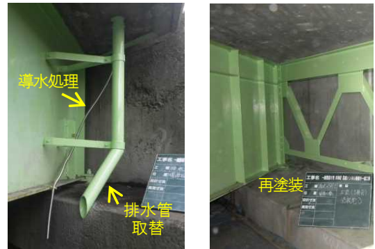
伸縮装置、排水管の止水処理 桁端部部分塗装
