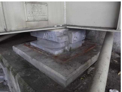
支承の取替え
