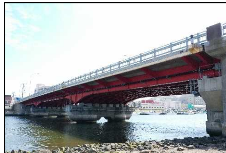
■一般国道39号 網走橋（網走市 1934年完成）
