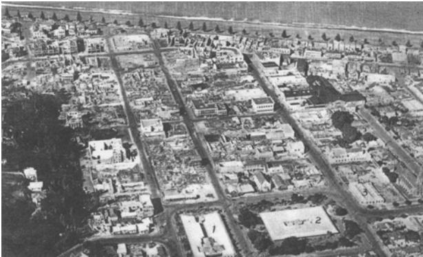
図6 瓦礫撤去後のネーピア中心市街地
