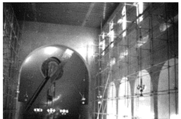
(高窓のステンドグラス設置のための足場) 斉藤秘書撮影
