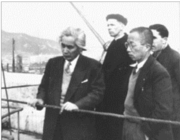
(鐘楼の屋上で工事現場をみる村野とラッサール神父)
