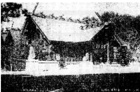
古写真1-15 新京神社（『大陸神社大観』から転載）。「新京神社本殿並に拝殿」とのキャプションあり。
