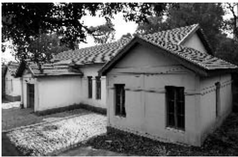
現況写真 8-1-3 旧拝殿。 元入母屋造の拝殿が切妻造に改変され、両脇に突き出した部分は後補。
