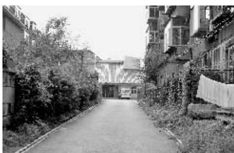
現況写真 3-5 元参道、正面奥に見える建物がクラブ ハウス。旧参道右手のコンクリートの塊は元の灯籠の基 礎。
