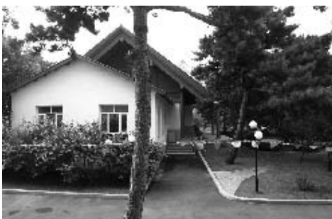
現況写真1-⑦ 旧新京神社拝殿南面。 旧拝殿棟を飾っていた勝男木・千木はなくなっている。
