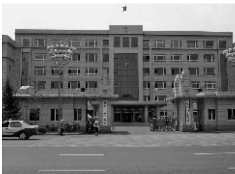
現況写真 5-5 市役所正面。かつての開原神社の背面にあたる。
