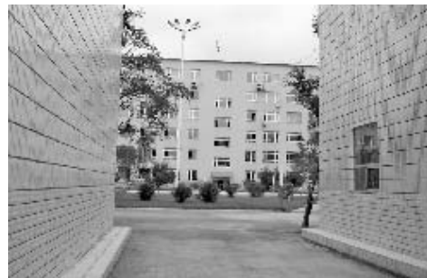
現況写真 5-4 現市役所の裏口
