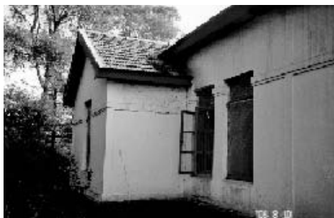
現況写真 8-⑤ 旧拝殿の背面。 拝殿の背面に弊殿が突き出ている。
