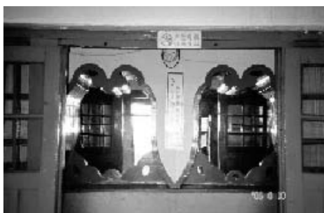
現況写真 8-⑦ 正面入口奥の火頭窓様の窓
