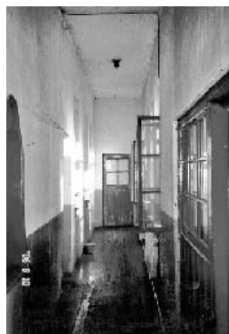
現況写真 8-⑧ 旧拝殿内部
