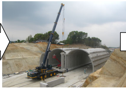
アーチカルバート設置状況
