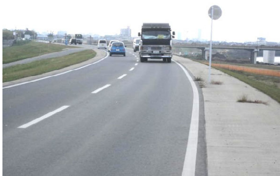
堤防道路整備状況
