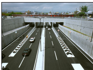
高速道入口付近 J R アンダー部 (福岡県施工)
