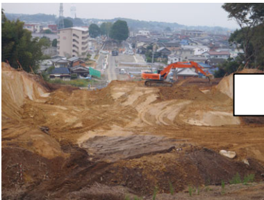
丘陵部掘削状況
