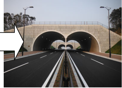
アーチカルバート完成
