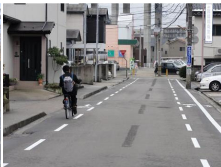
写真 I-2 車道左側部の車線内に帯状の路面表示を設置した事例
