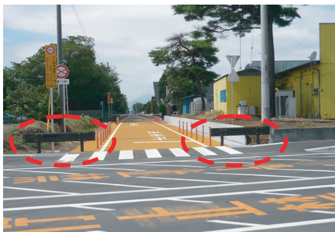
写真1 ガードレールの設置
