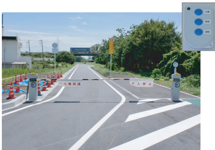
写真2 遮断機とリモコン
