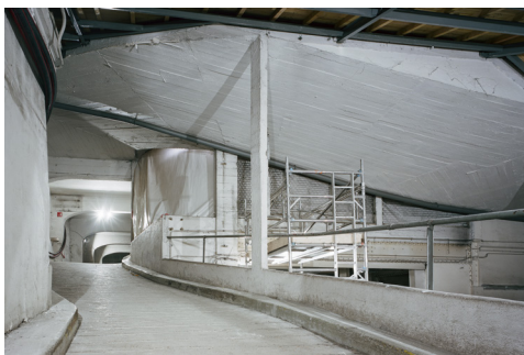
013 Fondation HCB, 79 rue des Archives, février 2017 Rampe d'accès des voitures aux étages de l'ancien garage qui a été détruite à la demande des architectes des bâtiments de France pour recréer la cour du XVIII e siècle. © Cyrille Weiner
