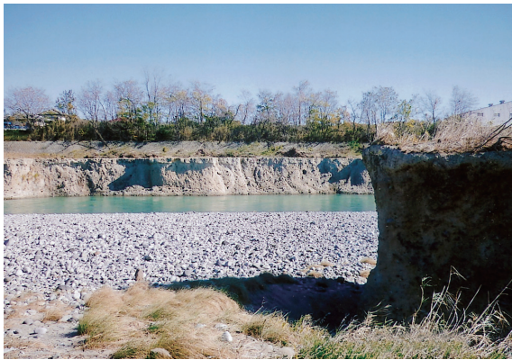
図18 左岸・新堀町の河岸段丘 手前右は軍艦島北端
