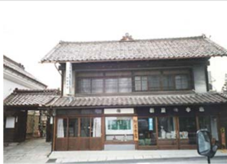
道路側主屋正面
