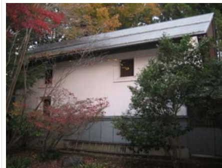
土蔵の外観(外壁・屋根は近年改修)
