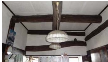
・建設当時のちょうな削りの梁(台所)
