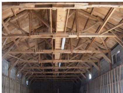
小屋組は 3 点トラス形式と推測される
