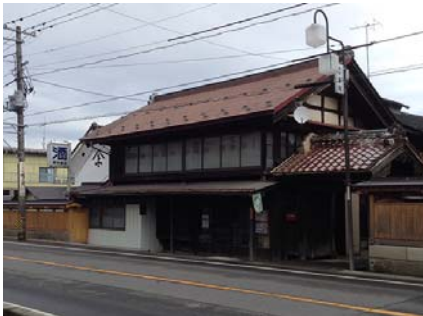
茨城街道・南西側からの店舗正面外観
