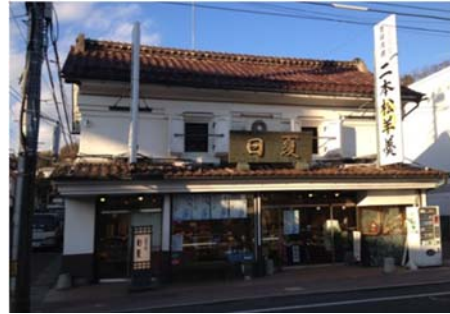
道路面南側外観
