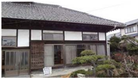
石の基礎の上に土台の設置 煙出しが設けてある寄せ棟の屋根
