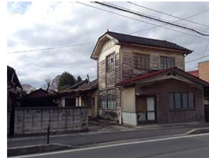
茨城街道・南東側からの正面外観
