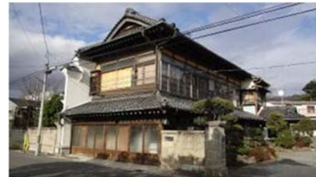
建築物全景 ・建築物正面出入口口左側にうだつの設置 ・正面出入口口上部にせいの高い梁の設置
