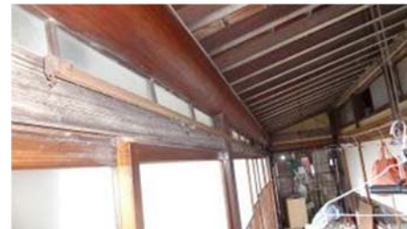
桁行き方向に1本ものの丸太の梁の設置
