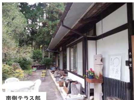
南側テラス部
