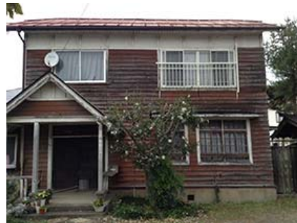
住宅正面南側外観 木塀の奥に中庭あり(東側)
