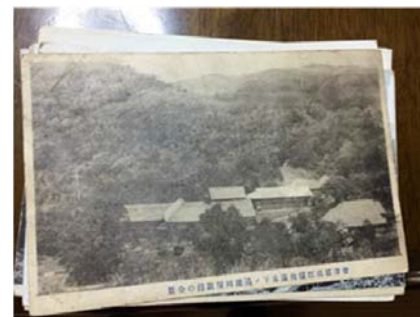
竣工当初の滝川屋旅館
