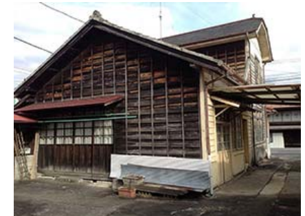
南西側からの外観
