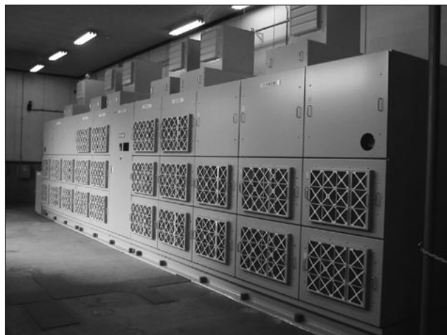
図4 大容量同期電動機用スタータ
