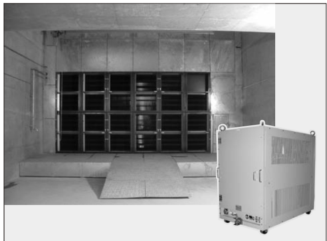
図32 電気集じん装置と交流高圧発生装置
