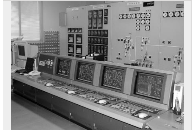
図 16 火力発電設備の計測制御システム
