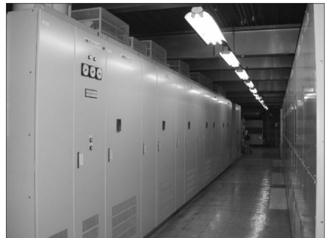
図2 主機用3レベルIGBTインバータ盤
