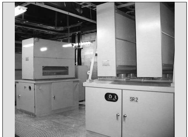
図2 整流器設備(左:新型,右:従来型)
