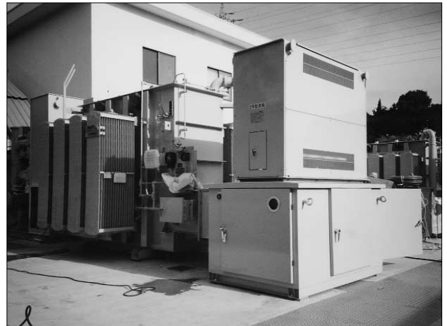
図4 純水沸騰冷却式シリコン整流器
